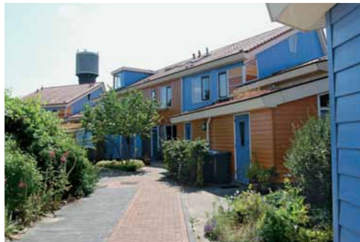
The neighbourhood is vehicle restricted, with no through traffic, but there is a dense network of footpaths, cycleways and playgrounds. De wijk is autoluw, in de woonwijk is geen doorgaand autoverkeer mogelijk. Wel is er een dicht netwerk van wandelpaden, fietspaden en speelplaatsen.
