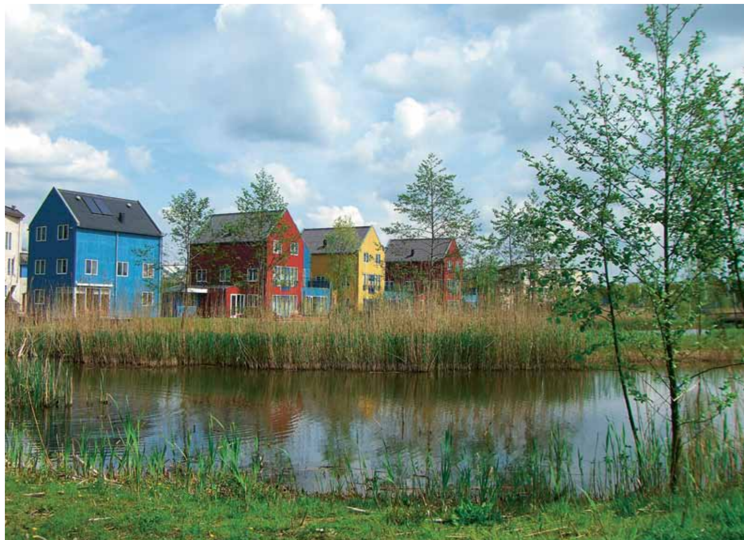
A water retention pond adds ecological value. Waterretentievijver met ecologische betekenis.
