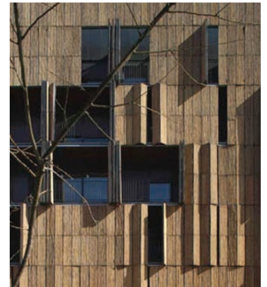
Gesloten houten gevel met gaten
