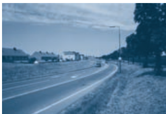
VERDIEPTE LIGGING VAN DE WEG IN MILTON KEYNES, ENGELAND.
