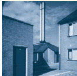
WK-INSTALLATIE IN ENSCHEDE (EDON).
