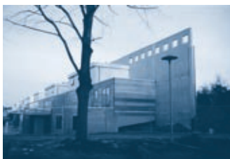
WONINGBOUW MET GEÏNTEGREERD GELUIDSCHERM LANGS HET SPOOR IN UTRECHT LUNETTEN.
