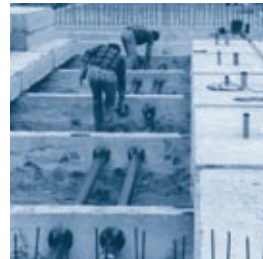
AANLEG PROJECT NUON WARMELEVERING.
