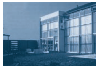
DE SERRE VAN DEZE WONINGEN IN SPIJKENISSE IS TWEE VERDIEPINGEN HOOG EN HEEFT UITSLUITEND VERTICAAL GLAS. HIERDOOR WORDT OVERVERHITTING EN NACHTELIJKE UITSTRALING VOORKOMEN. DE WONINGEN ZIJN EEN EG-DEMONSTRATIEPROJECT OP HET GEBIED VAN PZE.
