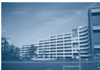
WONINGBOUW MET GELUIDWERING ACHTER DE GEVEL IN DELFT (ACHTERZIJDE).
